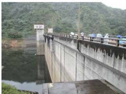
大松川ダムの上を歩きました。
